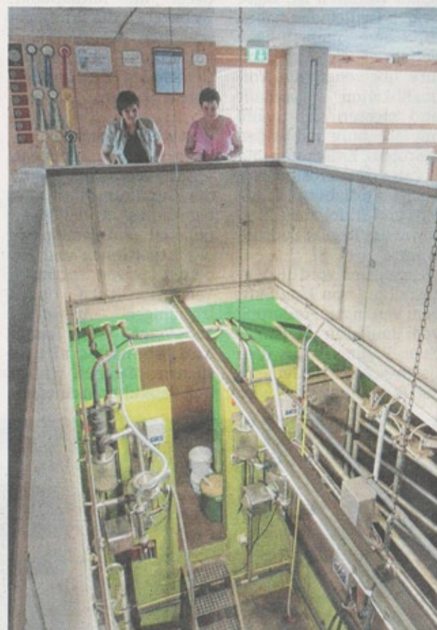
Von der Galerie aus können nicht nur Ziegen gefüttert werden, es bietet sich auch ein Einblick in technische Abläufe.
